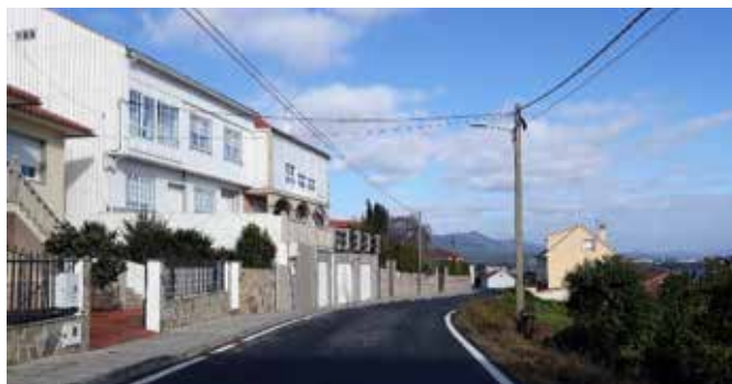
Ribeira (A Coruña). Tramo de dobre sentido con sinalización horizontal unicamente nos bordos.
